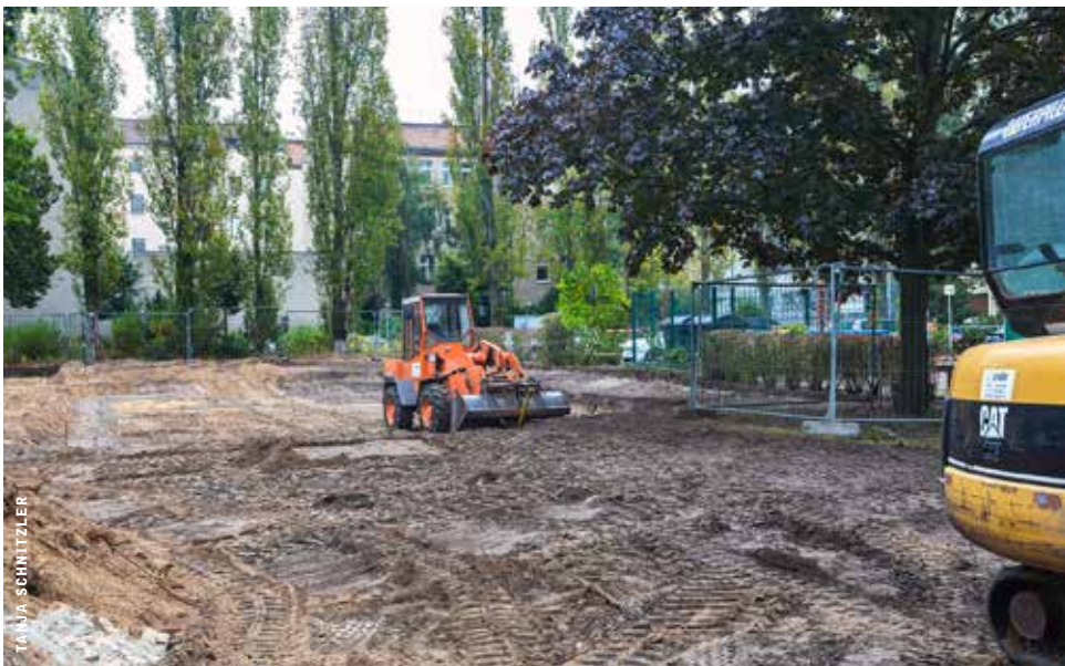
Bauarbeiten für den neuen Spielplatz Adam-/Jägerstraße.
