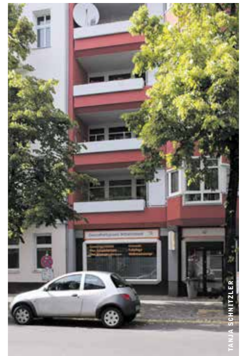
Diese Hausfassade in der Weißenburger Straße konnte mit Hilfe des Investitionsfonds einen neuen Anstrich erhalten.
